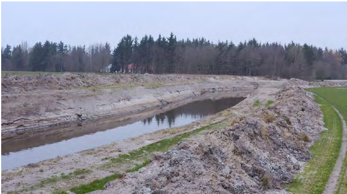
Figur 3. Eksempel på uddybning af et stort vandløb.
